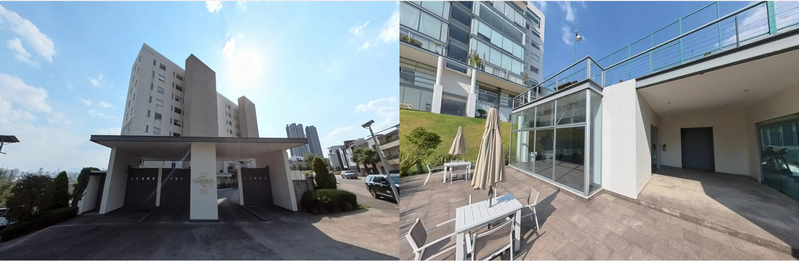
Caseta de vigilancia
